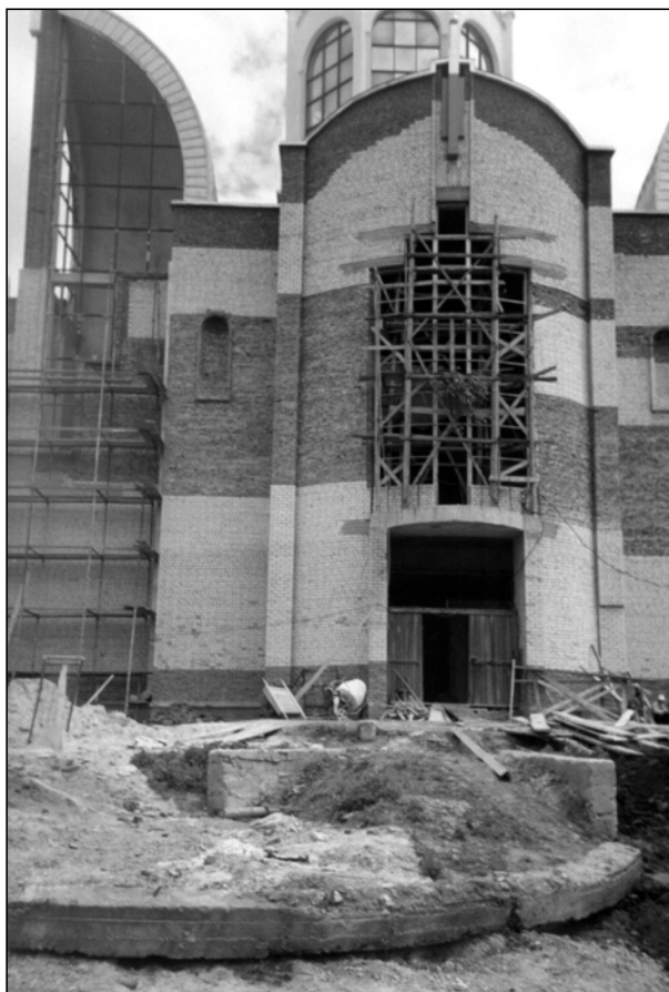
Будуймо храм — на будівництві собору УГКЦ Петра і Павла в Чорткові
