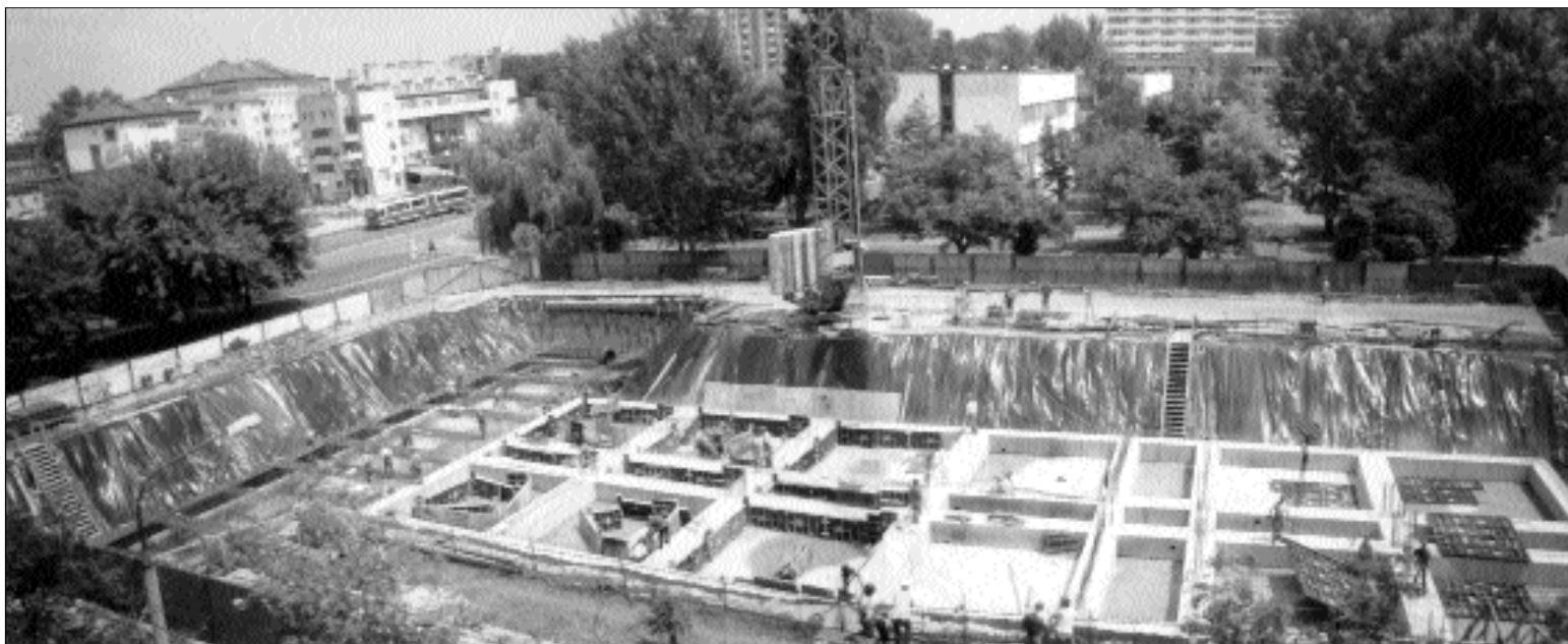
7 липня. Закінчення підцокольної фундаментної основи з литого бетону
