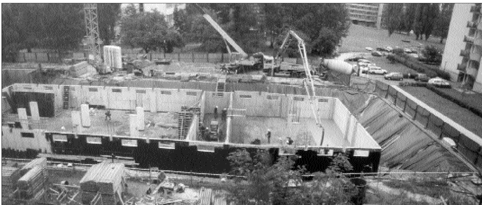
16 липня. Закінчення основи цокольного поверху з литого бетону
