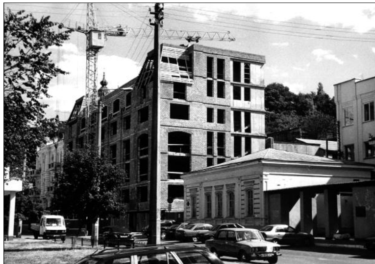
На Подолі, в заповіднику "Стародавній Київ" будеться багатоповерхова будівля, яка закриває панораму Андріївської церкви з боку вул. Флоровська і вул. Боричів тік. 2004 рік
