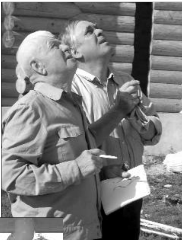
Для жерстяників Михайла Вовка та Михайла Павленка на будівництві дерев’яної церкви теж знайдеться робота. Але тільки після гонтарів
