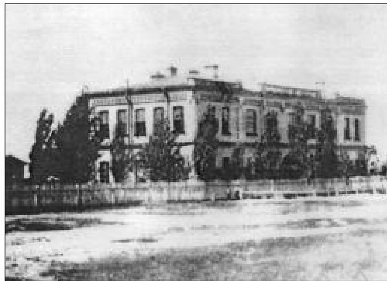
Будівля колишнього міського трикласного училища, в якому тепер розмістилася гімназія
