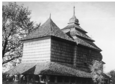
Після пожежі сподівання на реставрацію (храм початку 18-го ст)
