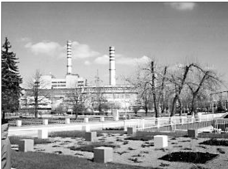
Електростанція в Стальовій Волі
