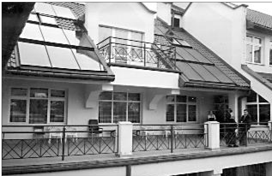
Центр для престарілих. Сонячні батареї на даху будинку
