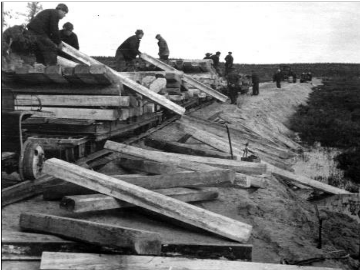
Будівельники залізниці Салехард—Ігарка на розвантажувальних роботах. 1949 р. (архівне фото)
