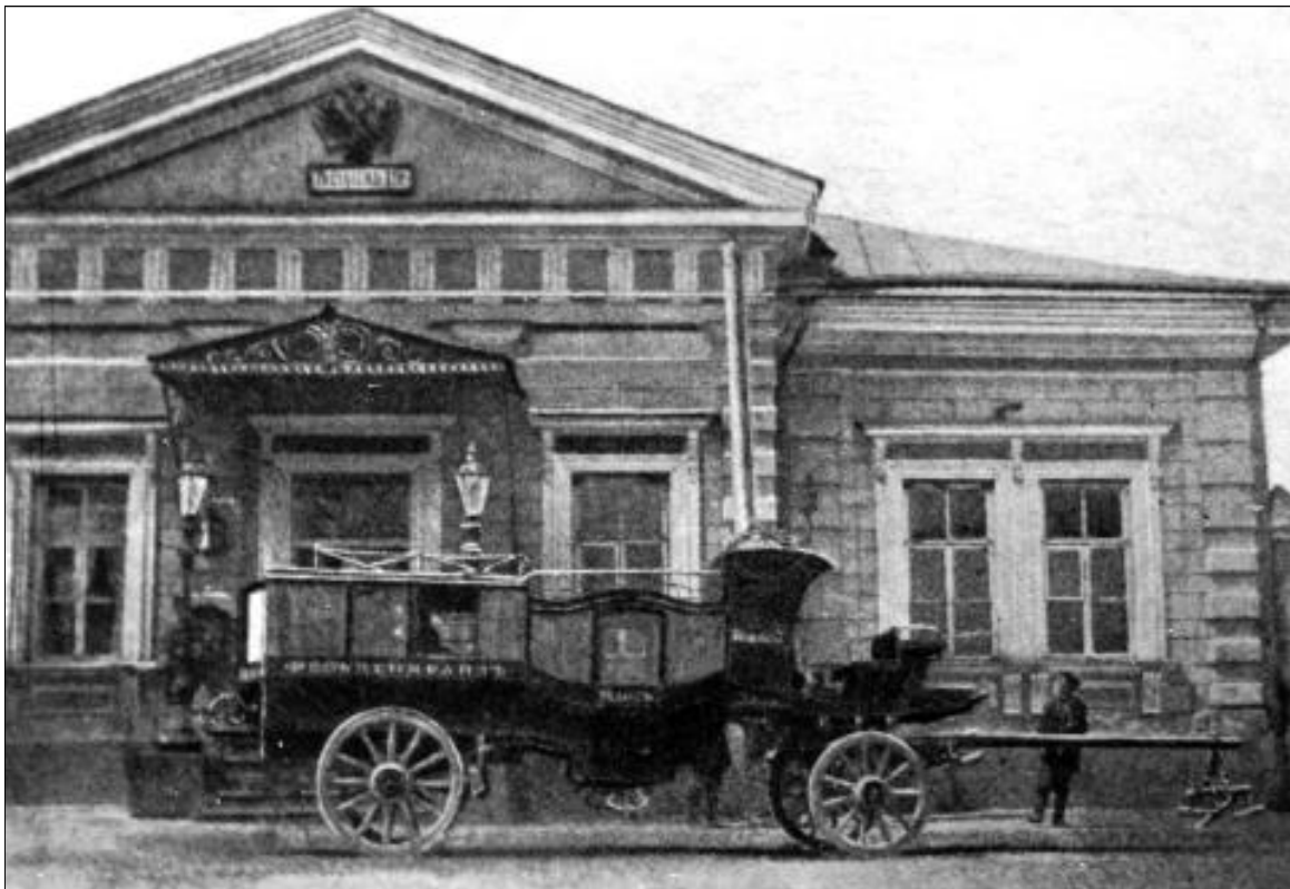
Фасад Поштового будиночка. Фото початку XX ст.
