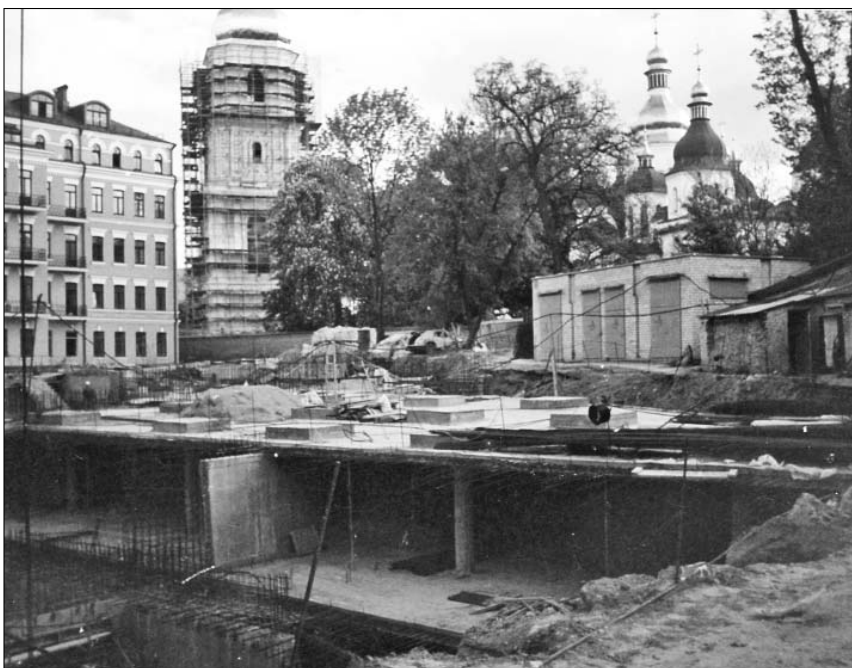
Будівництво підземного двоповерхового паркінга біля фундаментів Софійського собору. Фото 2001 р.
